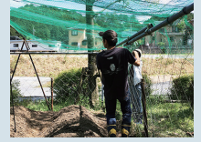
獣害防御柵を設置するための杭打ちと、網張り作業
