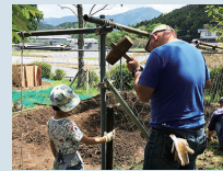
獣害防御柵を設置するための杭打ちと、網張り作業
